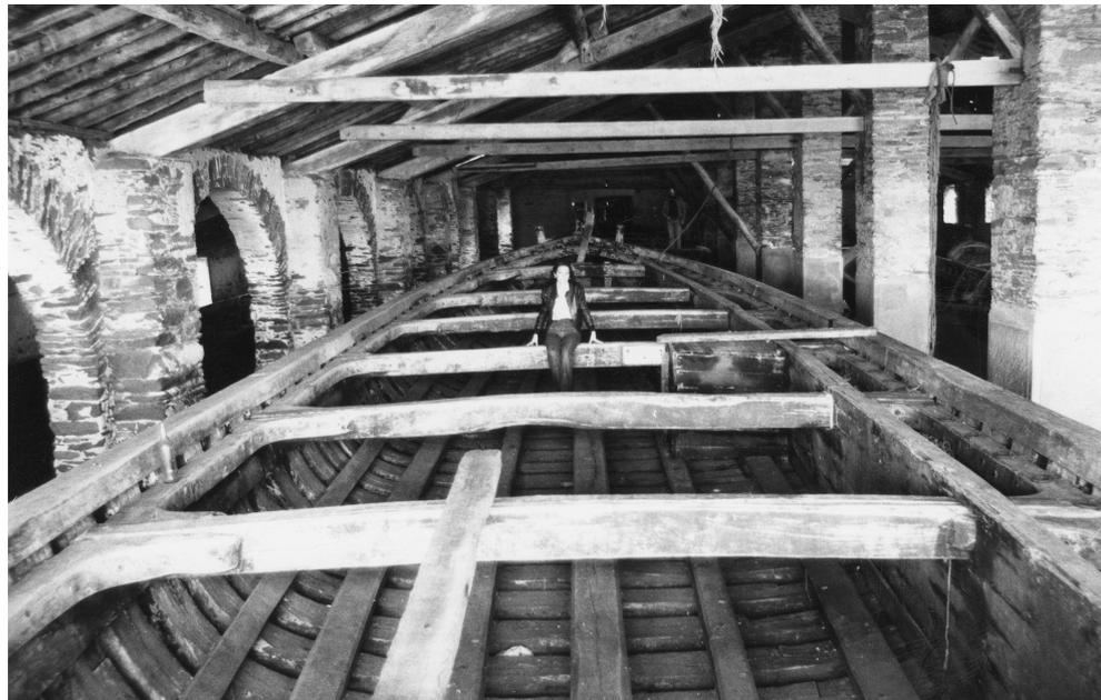
metri di rete per volta e, come per il Capo Rais, era costruito con il cosiddetto sistema misto: robuste ordinate, incastrate fra chiglia, paramezzali e sovrparamezzali, oltre ai correnti longitudinali. Non aveva ponti sulle murate, solo una piccola coperta sulla prua e sulla poppa quadra.
